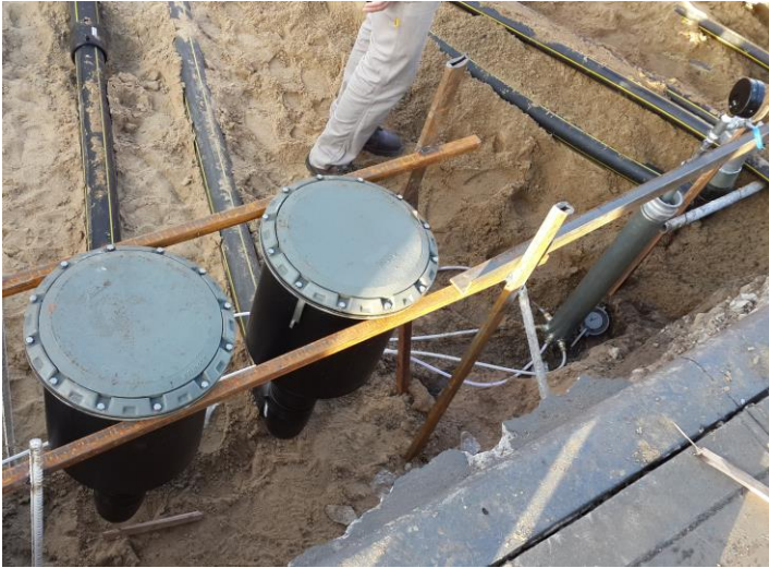
YPF Morón –Baldes con racord soldados a la tubería de descarga
